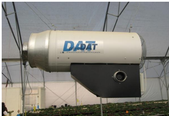
شکل ۳- کاربرد دمنده هوای گرم در گرمایش گلخانه تولید توت فرنگی.
