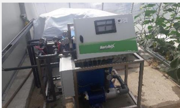
شکل ۳-۵. سامانه‌های کنترل گلخانه
