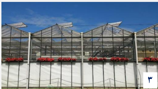
شکل ۱-۲. تنوع شکلی انواع گلخانه. (۱) گلخانه طرح اسپانیایی با سقفی گنبدی شکل و پوشش پلی‌کربنات؛ (۲) گلخانه با کمان قوسی و پوشش نایلون؛ و (۳) گلخانه طرح هلندی با سقف A شکل و پوشش شیشه
