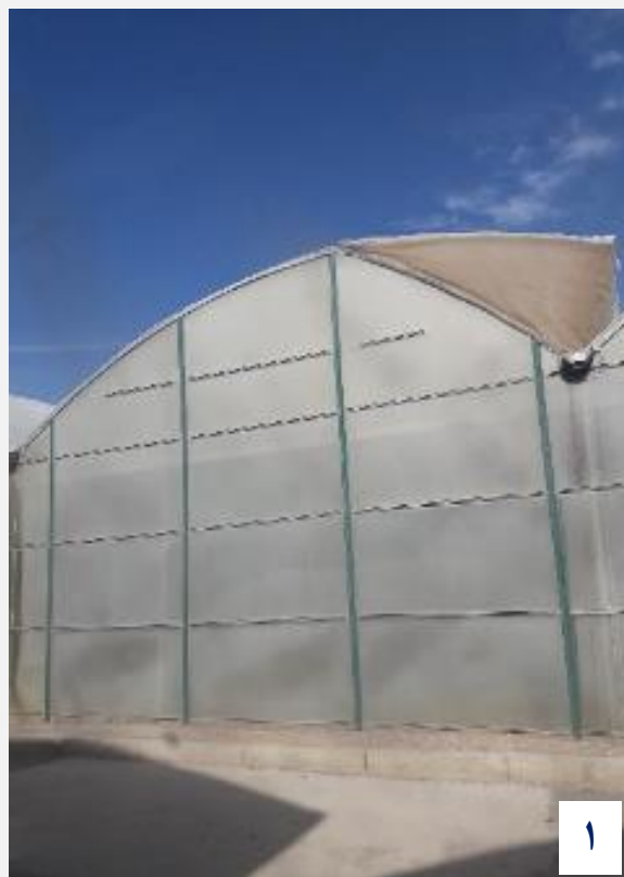
شکل ۱-۲. تنوع شکلی انواع گلخانه. (۱) گلخانه طرح اسپانیایی با سقفی گنبدی شکل و پوشش پلی‌کربنات؛ (۲) گلخانه با کمان قوسی و پوشش نایلون؛ و (۳) گلخانه طرح هلندی با سقف A شکل و پوشش شیشه
