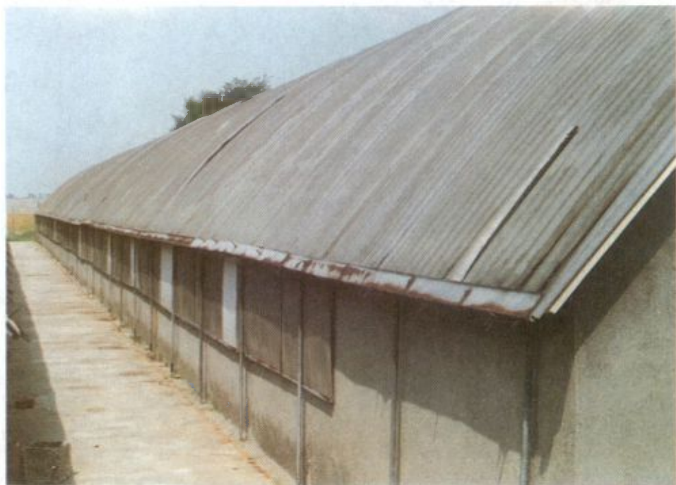
شکل ۱۰۴ : سالن با دیوار جانبی باز که با دیوارهای کشویی پیش‌ساخته تبدیل به سالن بسته شده است.
