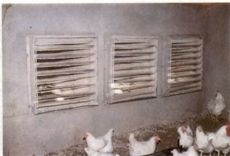
شکل ۸۲: دریچه ورود هوا با شیارهای هدایت هوا
