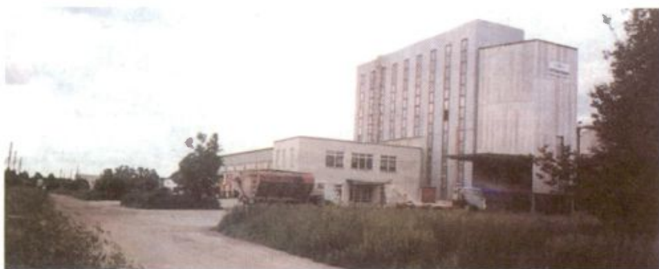
شکل ۱۰۱: ساختمان پرورش طیور سه طبقه و سالن‌های پرورش طیور از جنس پلاستیک
