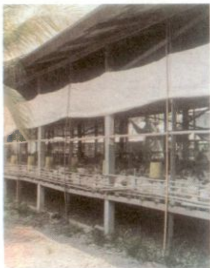
شکل ۱۰۳ : سالن پرورشی با دیوار جانبی باز در منطقه‌های مرطوب
