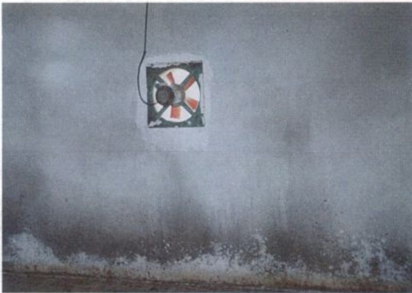
شکل ۸۹: چگونگی نصب هواکش‌ها در دیوار
