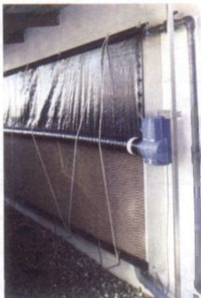
شکل ۹۶ : سیستم خنک کننده با پوشال خیس
