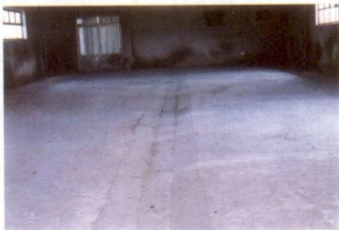
شکل ۶۹: کف سالن‌های پرورش طیور با کانال کف
