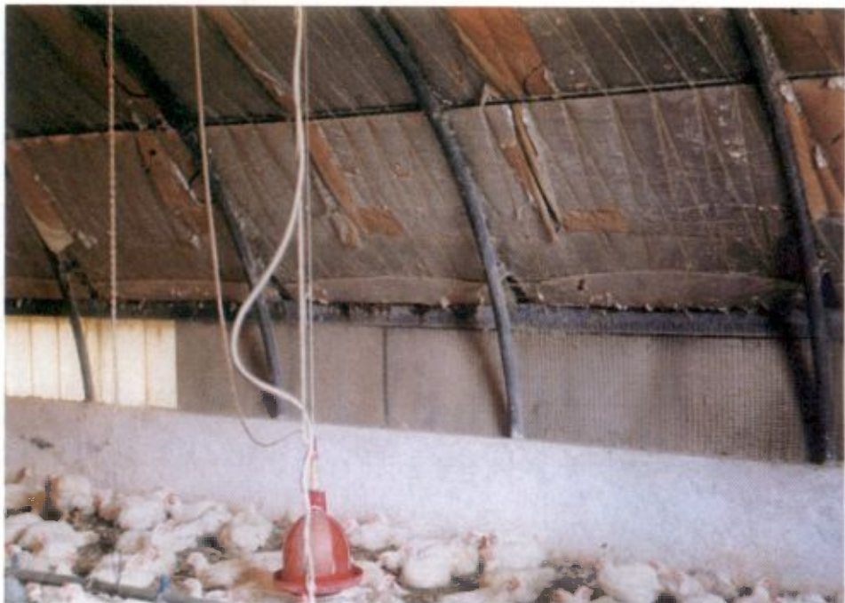
شکل ۸۳ : عایق‌بندی سقف سالن
