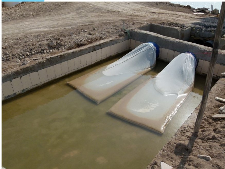
فیلتراسیون با دو توری (۵۰۰ و ۱۰۰۰ میکرون)
